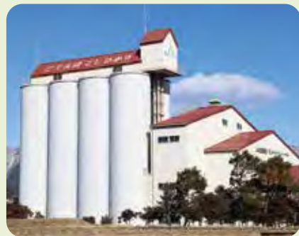
カントリーエレベーター
