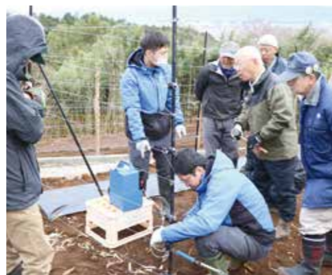
▲増加するシカの被害を防ぐため、JA職員が講師となり8段張りの電気柵を設置
