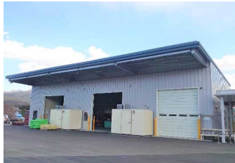
すその営農経済センター倉庫建て替え (なんすん地区)
