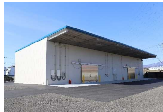
北郷営農経済センター米低温倉庫建て替え (御殿場地区)
