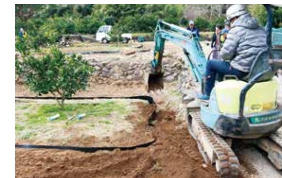
専用シートの埋設作業
