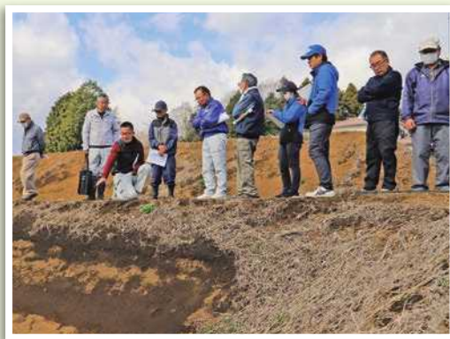
センチピードグラスの種子を吹き付ける箇所を確認する生産者やJA職員
