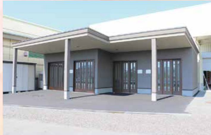
▲新設した小規模葬専用ホールの外観
