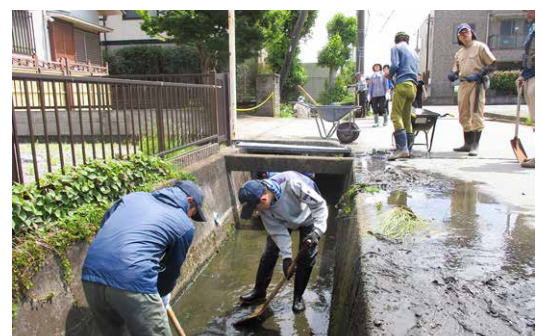
■1支店1協同活動「浚渫作業」
