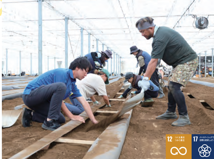
長さ約50mの遮根シートを土の中に敷設
